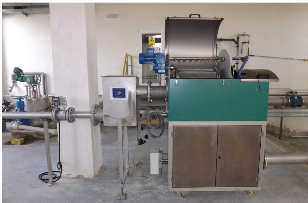
obr. 2 Mikrosíťový filtr se zabudovaným UV reaktorem
