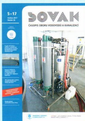
LIFE2Water – pilotní ultrafiltrační jednotka, ČOV Brno-Modřice, Brněnské vodárny a kanalizace, a. s.
